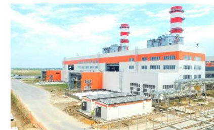
ТЭС «Ударная» (строительство)
