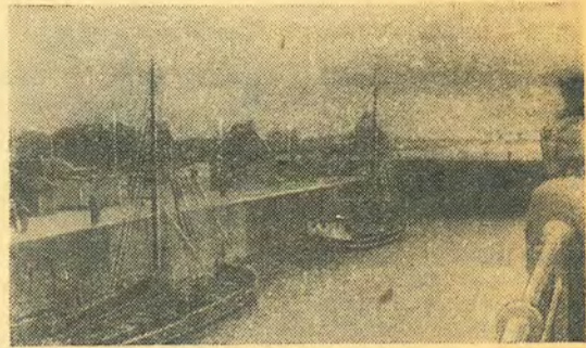
Шлюзы Кильского канала.
