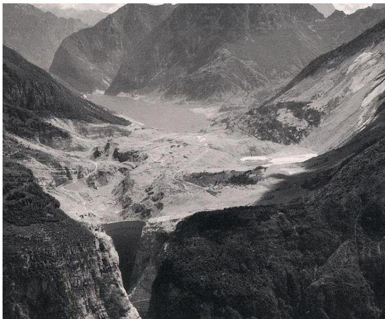
**Рис. 2.** На фото плотина Вайонт находится в нижнем левом углу, справа — место, откуда сошел оползень
