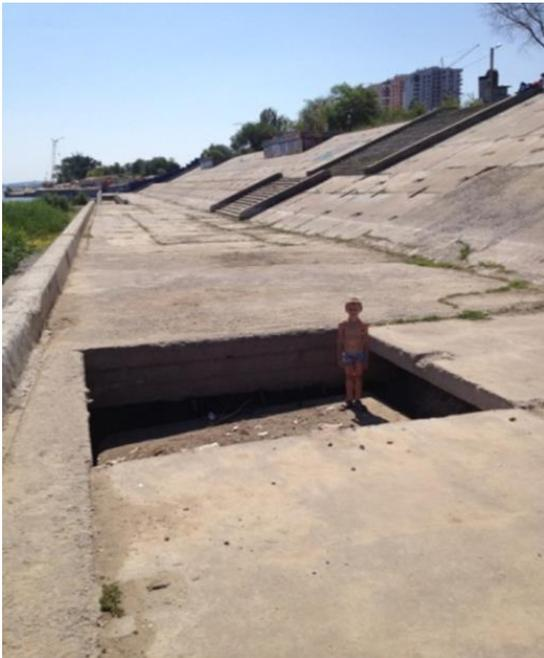
**Рис.3.** Провал плиты, примыкающей к нижнему ростверку, разграничивающему укрепленный склон и пойму р. Волга
