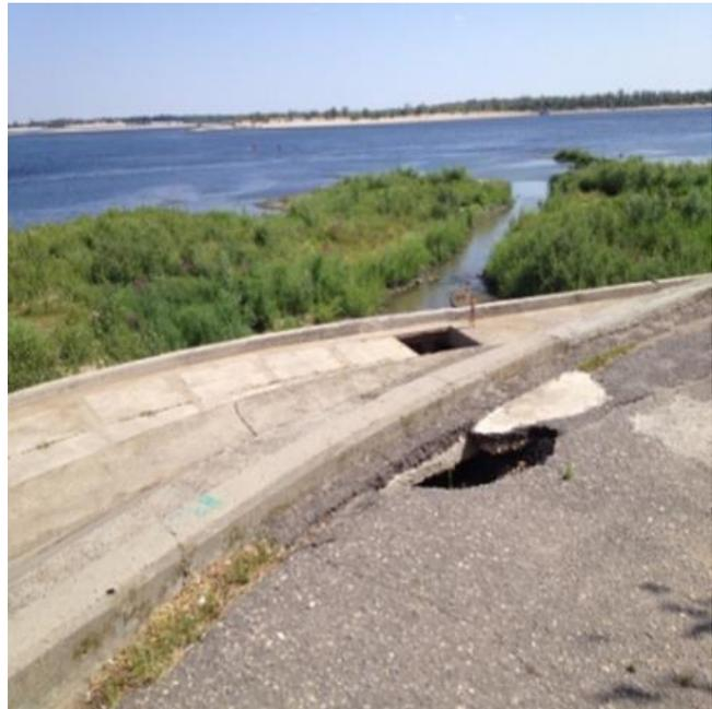
**Рис.4.** Суффозионный провал в верхней части откоса. Направление выноса грунта в сторону провала плиты в нижней части склона.
