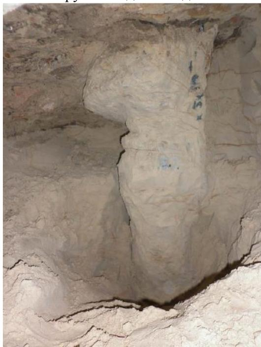
**Рис.3.** Буроинъекционная свая под подошвой фундамента корп. 1 диаметром от 50 см в верхней части до 20 см в нижней. Свая продолжается в нижележащих песках
